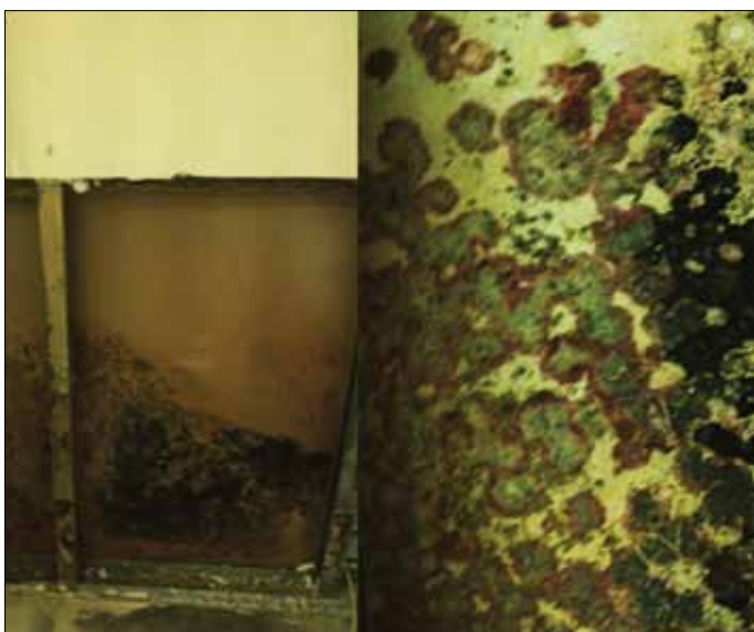
3. kép: Rejtett Stachybotrys telep egy budapesti iskola falában (a szerző felvétele)
